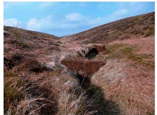
Szénabálával elrekesztett kisvízfolyás a felső vízgyűjtőn
