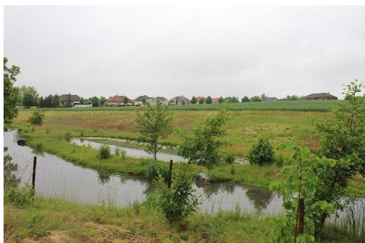
Figura 1 - În Hostovice, Republica Cehă, riscul de inundații a fost redus prin refacerea meandrelor unei secțiuni de pârâu interior și aplativarea zonei sale inundabile, creându-se un parc atractiv pe locul unui fost canal. (Fotografie: Viktor Mátyás Farkas, WWF HU)
