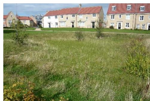
Figura 10 - Bazin de stocare a apelor pluviale, potrivit pentru inundație temporară, care funcționează și ca zonă verde. (Forrás: susdrain.org)
