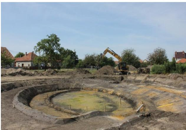
Figura 40 - Crearea unei geometrii diverse și neregulate a albiei la Ruzsa. Taluzurile plate și terasele cu mai multe niveluri alternează. Crearea acestora necesită mai multă atenție și muncă din partea constructorului și reduce volumul rezervorului în comparație cu cel mai abrupt plan înclinat. Malul plat oferă siguranță și un habitat divers pentru viața acvacătică. (Fotografie: Mátyás V. Farkas, WWF HU)
