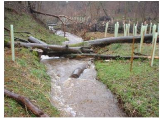
Rönkgát, mellette az ártéren ültetett facsemeték. Az erdősített ártéren növekszik az érdesség, így a rönkgát által kiterelt víz folyása tovább lassítható.
