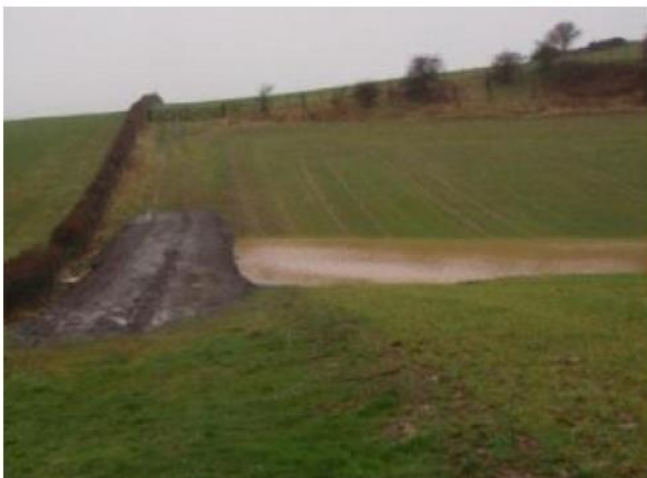
Balra: földtöltéssel elrekesztett ideiglenes vízfolyás. A víz egy megemelt áteressen lassan távozik a tóból, az áteresz bukószintje alatt a tó képes a szántóról lemosott termőföldet és szerves anyagot megtartani. Jobbra fa gát zsilippel. A zsilippel a gazdák szabályozhatják a leengedés gyorsaságát, vagy megtarthatják a vizet pl. aszály esetén.
