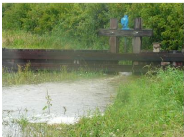
Balra: földtöltéssel elrekesztett ideiglenes vízfolyás. A víz egy megemelt áteressen lassan távozik a tóból, az áteresz bukószintje alatt a tó képes a szántóról lemosott termőföldet és szerves anyagot megtartani. Jobbra fa gát zsilippel. A zsilippel a gazdák szabályozhatják a leengedés gyorsaságát, vagy megtarthatják a vizet pl. aszály esetén.
