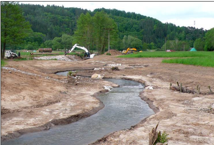
10. ábra A szélesebb főmederben a ( Q_5 vízz szállító képesség) az átfolyási keresztmetszet az átlag-vízhozamra van szabva
